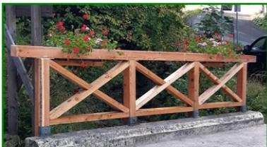
Aufgrund des schlechten Zustandes des Geländers bei der Klauswirtbrücke wurde Günter Thron mit den Arbeiten beauftragt, das Brückengeländer zu erneuern. Die Kosten für das Lärchenholz (Fa. Bauholz Gruber) und die Arbeitszeit betragen rund € 1.800,—.
